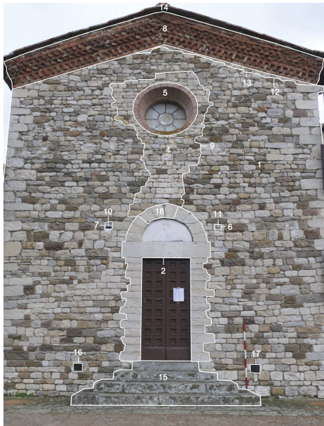
Fig. 6 - La chiesa di S. Tommaso a Baroncelli: analisi stratigrafica del prospetto di facciata.
