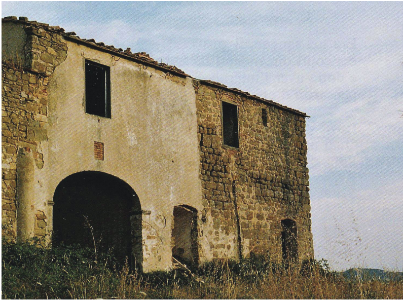
Fig. 9 - Montemasso, particolare della torre nel 1988 (foto M. Casprini).
