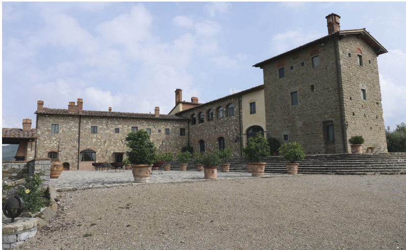
Fig. 8 - Montemasso, veduta generale del complesso architettonico dopo i restauri.
