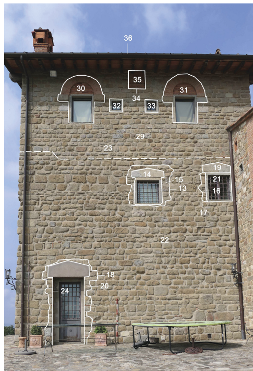
Fig. 11 - Montemasso: analisi stratigrafica del prospetto esterno est della casatorre (CF 1) dopo i restauri: a tratteggio è indicata la quota della parte ricostruita.
