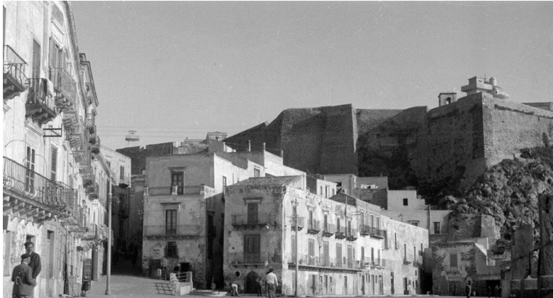
TORRI DI SORVEGLIANZA DEL CENTRO RACCOLTA PROFUGHI VISTE DA MARINA CORTA. IN ALTO A SINISTRA LA TORRE DI SUD-OVEST IN ALTO A DESTRA LA TORRE SUD. ENTRAMBE LE TORRI SONO STATE RIMOSSE NEL CORSO DELLA SISTEMAZIONE DEL CASTELLO TRA IL 1950 ED IL 1954.
