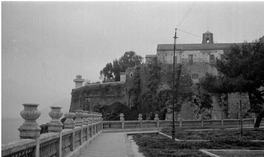
TORRE DI SORVEGLIANZA LATO DI NORD - EST VISTA DA PIAZZA MAZZINI
