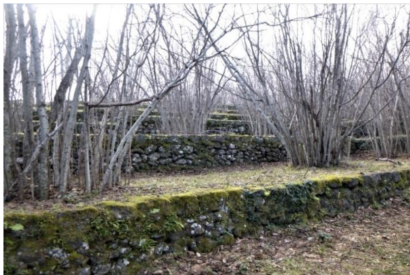
Fig. 6 – Etna, versante orientale (Sant'Alfio): nocioleti con reticolo di muretti a secco e relativi terrazzamenti recentemente ripristinati (ph. S. Privitera, 2019).
