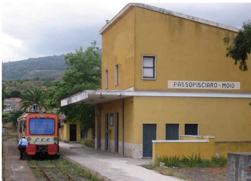
Fig. 7 – Stazione della ferrovia Circum-Etna. Passopisciaro
