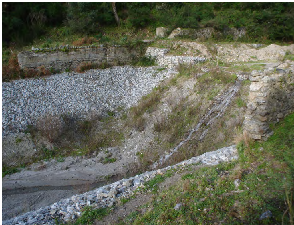
Fig.6 - Argini in materiale naturale della Fiumara Ciccia (Monti Peloritani di N.E.) costruiti per rinforzare i vecchi muri in pietra e mattoni. (Foto P. Mazzeo)
