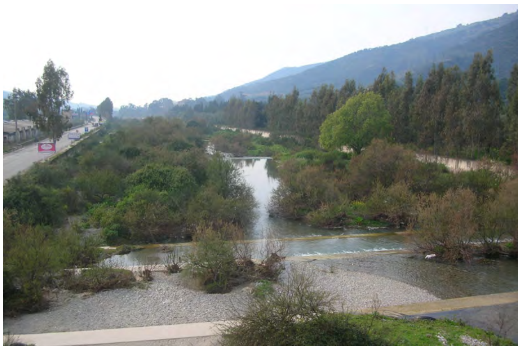
Fig. 2 - La Fiumara di Fitalia scaturita negli alti Nebrodi si riversa nel tratto mediano del suo corso nella fiumara di Zappulla. Si notino i “gradini” creati per rallentare il flusso delle acque durante la stagione delle piogge. La creazione della strada che collega i comuni montani alla costa, sulla riva sinistra dell'alveo, ha comportato la costruzione di nuovi argini che ne riducono l'ampiezza. (Foto G. Ingrilli)
