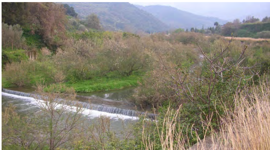
Figg. 3 e 4 - La Fiumara di Naso o di Sinagra nei pressi dei territori comunali degli omonimi comuni. Si notino, anche in questo caso, gli argini e i “gradini” costruiti per rallentare il flusso dell’acqua ed evitare eventi calamitosi come l’alluvione di Sinagra degli anni ’60. (Foto G. Ingrilli)
