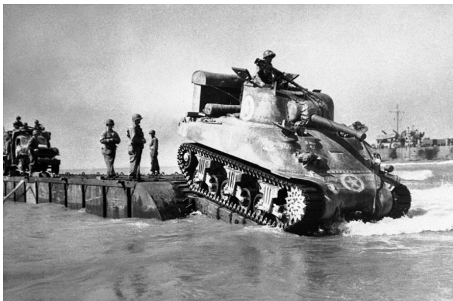
Fig. 11 - Carro armato «Sherman» americano: 40 t.- 400 cv – V.max. = 50 Km /h – cn. da 75 – 1 mtr.12.7 – 2 da 7.62 – cor. = 80 – 50 mm.- detto «Ronson» poiché facilmente incendiabile.
