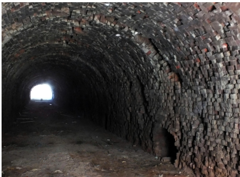
FIGURA 5B. Struttura interna della fornace Hoffmann di Venetico. Photo by M. Franzone.
