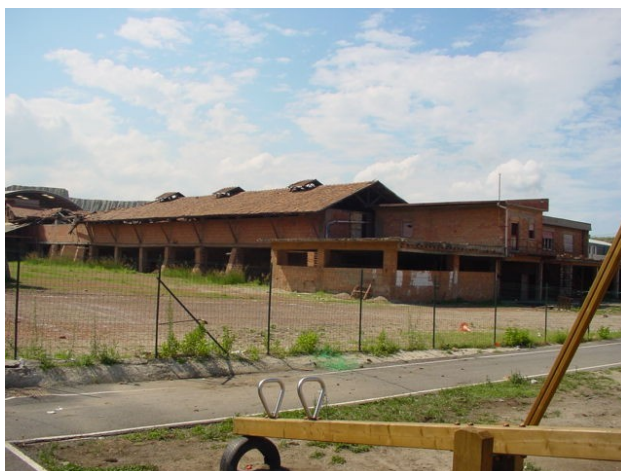
FIGURA 12. Panoramica della fornace Hoffmann, con annessi uffici, prima dei lavori di riqualificazione dell'area Condor. Si noti nella parte posteriore della fornace il crollo della copertura. (Fonte Comune di Venetico)
