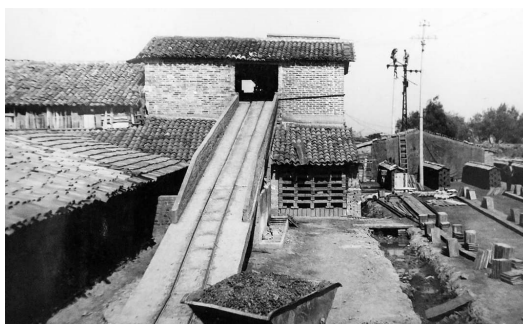
FIGURA 8. Particolare della rampa dello stabilimento dei La Fauci e del carrello a Venetico anni '50. Si notano, a destra, le pile di laterizi cotti in fase di raffreddamento. (Fonte Facebook)
