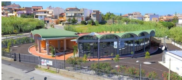
FIGURA 11. Veduta del Museo dell'argilla, realizzato all'interno della struttura dell'ex mercato coperto di Spadafora. (Fonte Tempostretto)
