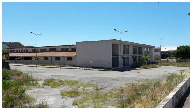
FIGURA 13. Panoramica della fornace Hoffmann dopo i lavori di riqualificazione e messa in sicurezza eseguiti dal Comune di Venetico. In primo piano, gli ex uffici dello stabilimento Condor sono stati trasformati in istituto scolastico.
